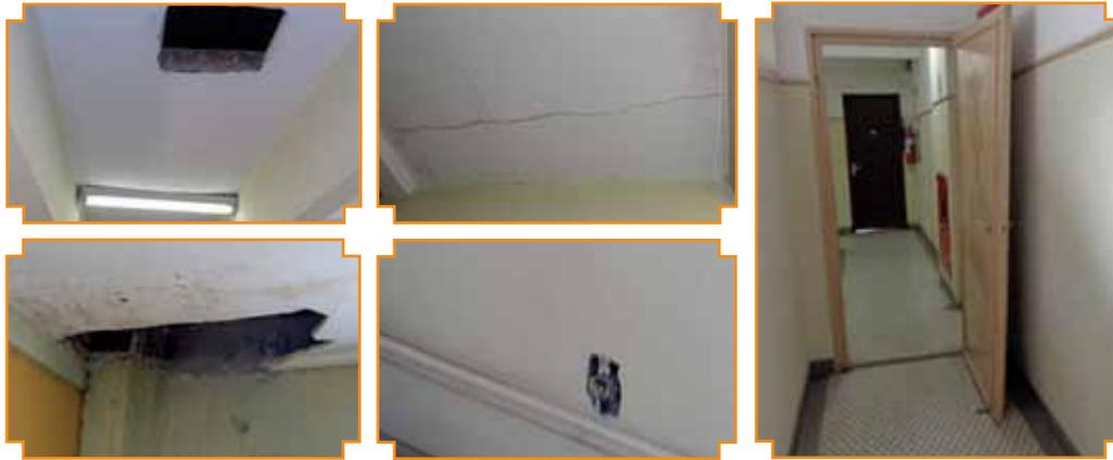
No 10º andar, fissura e buracos no teto. No detalhe, tomada exposta. À direita, porta corta-fogo empenada.
