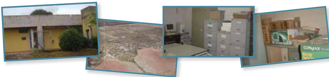
Da esquerda para a direita: 1) má conservação da fachada: aparência de abandono; 2) calçamento na frente do prédio destruído; 3) mobiliário não apresenta condições de uso; 4) falta de espaço
