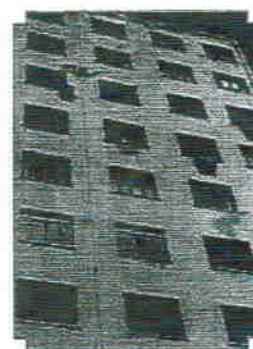
Na fachada externa, tinta e argamassa se desprendendo. Risco para procuradores, servidores e transeuntes.
